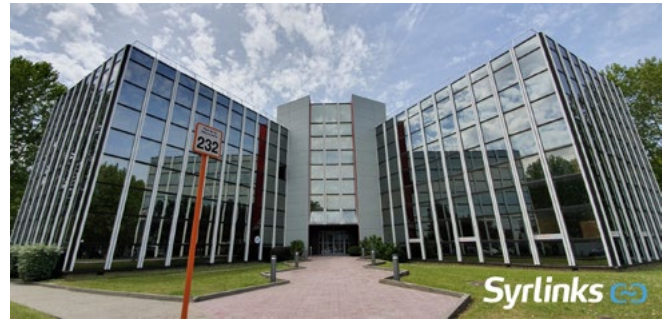
Les nouveaux locaux Syrlinks, 232 rue de la découverte à Labège. ©Syrlinks
